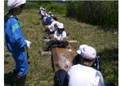
松坂地区の木道整備
