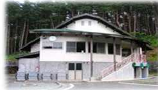
▲板橋沼キャンプ場 管理棟
